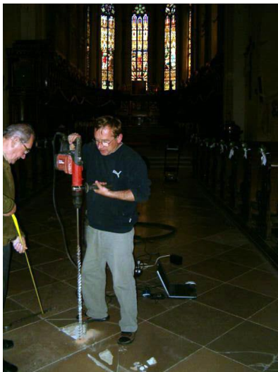
1. vrtanie po odkrytí dlažby
