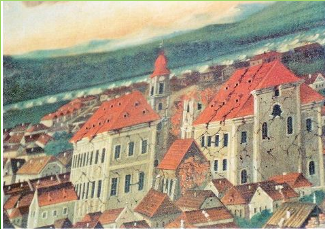
Obráz neznámeho autora zachytáva Komárno po zemetrasení s puklinami na domoch. Reprodukcia maľby: GFU SAV
