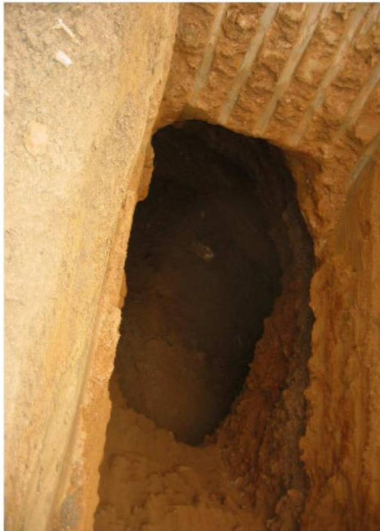
Abb. 4: Freilegung des durch die geophysikalische Untersuchung festgestellten Hohlraumes (ca. 60 m 3 ) mit einer Überlagerung von etwa 3,5 m
