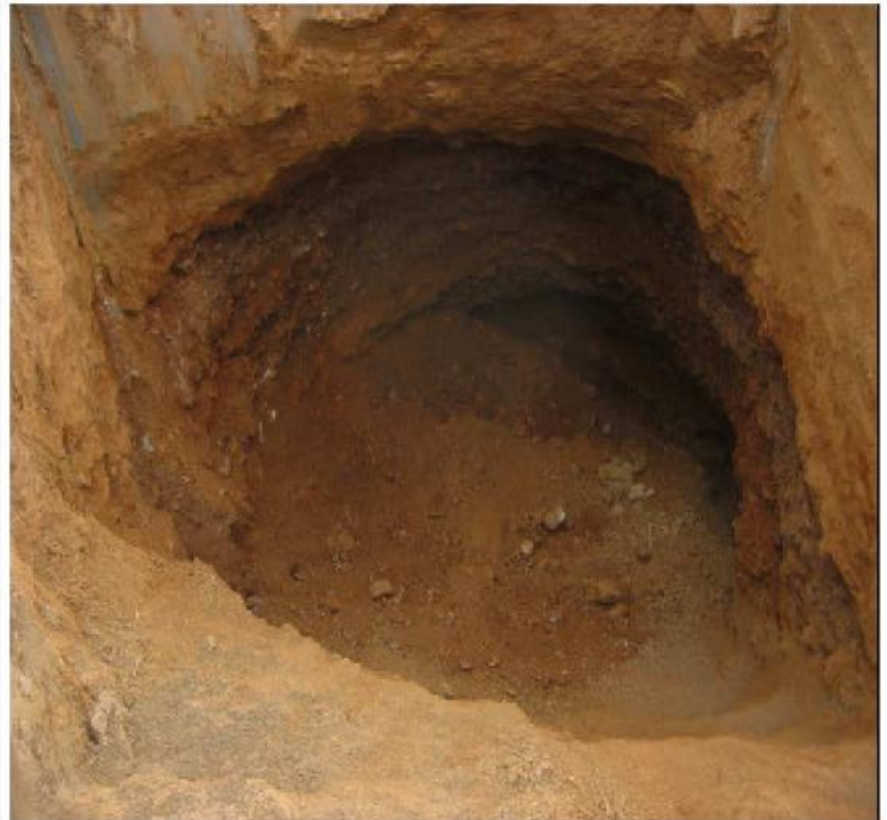
Abb. 4: Freilegung des durch die geophysikalische Untersuchung festgestellten Hohlraumes (ca. 60 m 3 ) mit einer Überlagerung von etwa 3,5 m
