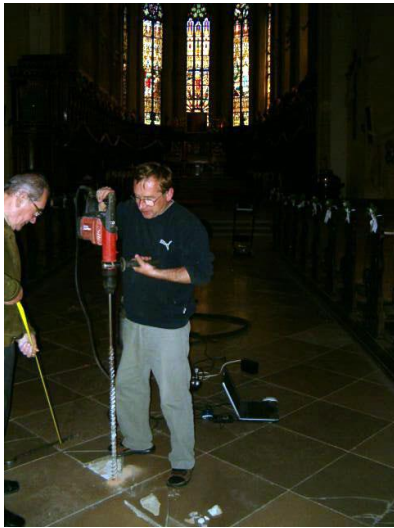
1. vrtanie po odkrytí dlažby
