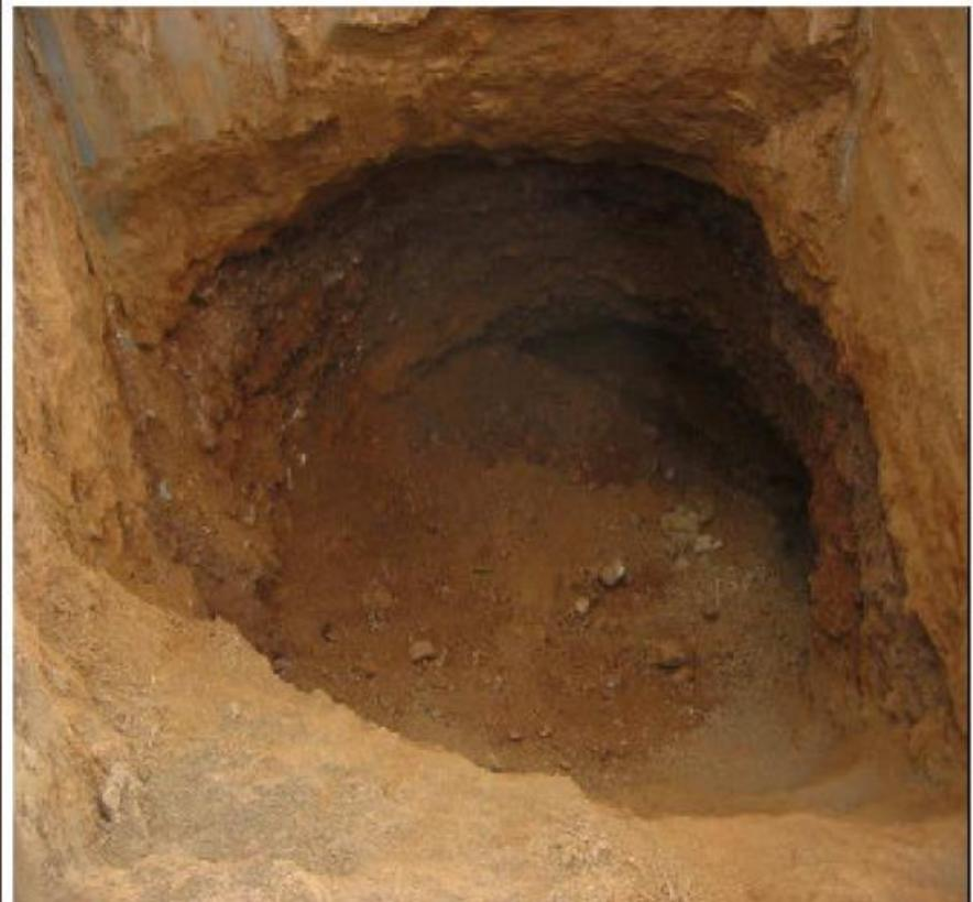
Abb. 4: Freilegung des durch die geophysikalische Untersuchung festgestellten Hohlraumes (ca.  $60 \text{ m}^3$ ) mit einer Überlagerung von etwa 3,5 m
