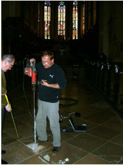
1. vrtanie po odkrytí dlažby
