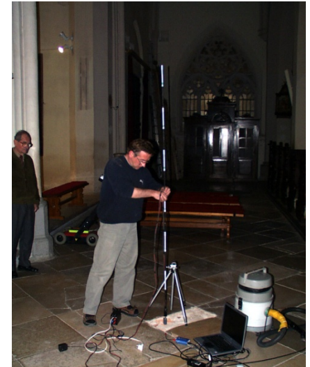
3. vsunutie kamery do otvoru
