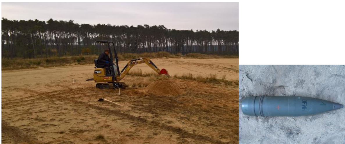
Obr. 7.60 Vľavo: fotografia zachytávajúca výkopové práce, ktoré boli potrebné na realizáciu umiestnenia projektílov 100 mm kalibru v rámci testovacej plochy na leteckej strelnici Rohožník. Vpravo: inertná tanková strela kalibru 100 mm, použitá v rámci vytvorenej testovacej plochy (projektil je položený na povrchu plochy, tesne pred jeho zakopaním).
