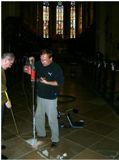
1. vrtanie po odkrytí dlažby
